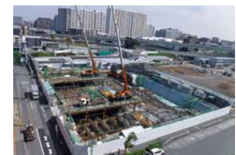
施工中の状況(先行工区)
