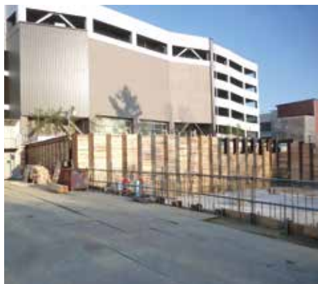
パークライフ棟地下1階床施工状況
